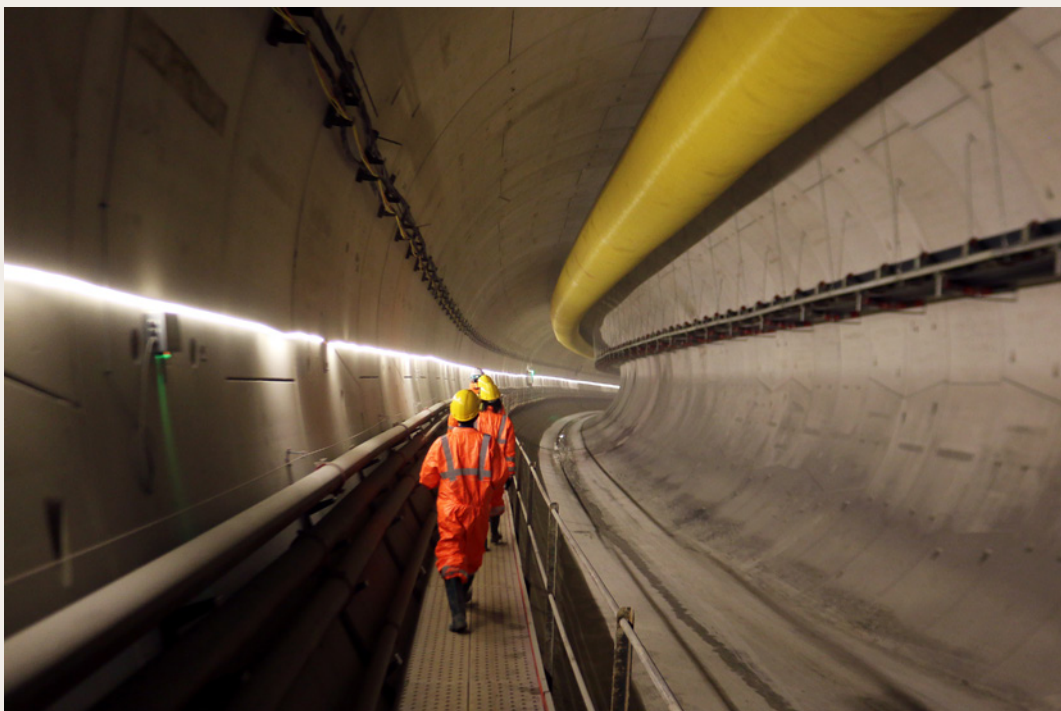
Construction souterraine de la ligne 15 Sud du Grand Paris Express. © FNTF
