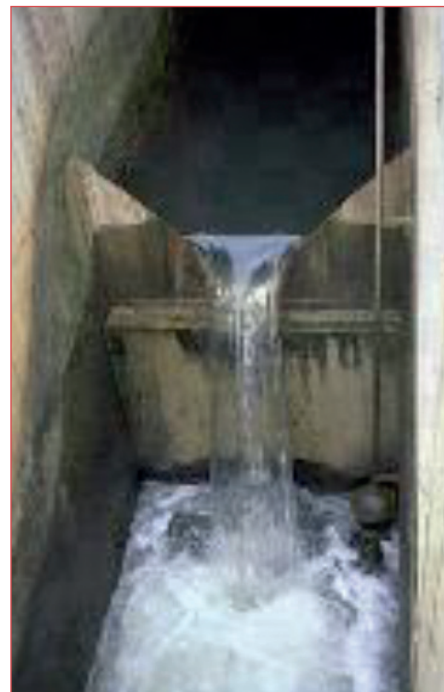
Figure 6 : canal de mesure avec déversoir triangulaire
