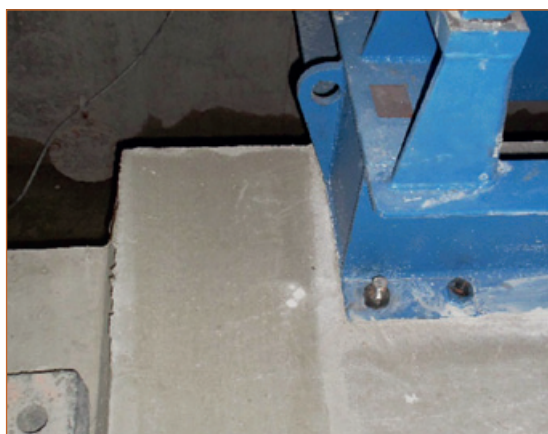
Boîte de coulée + barre d'ancrage + crosse d'ancrage + cale de réglage + châssis
