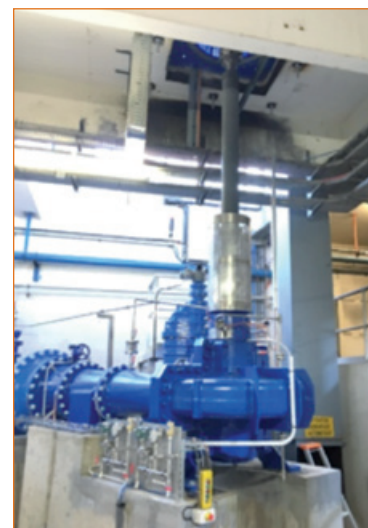
Pompe à plan de joint verticalisée
