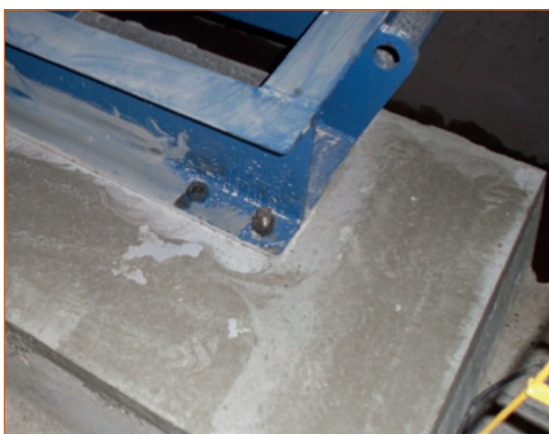
Boîte de coulée + barre d'ancrage + crosse d'ancrage
