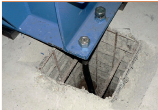
Boîte de coulée + barre d'ancrage + crosse d'ancrage + cale de réglage + châssis
