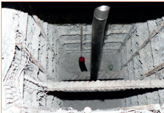
Boîte de coulée + barre d'ancrage + crosse d'ancrage
