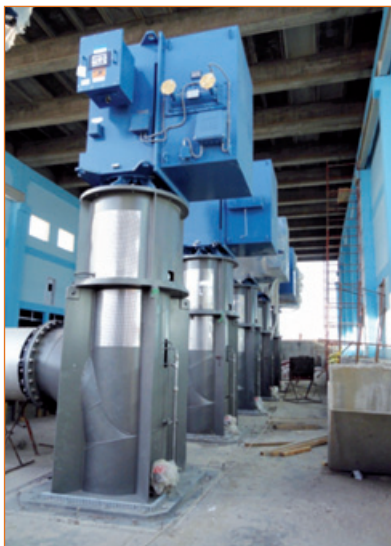
Pompes verticales à ligne d'arbre
